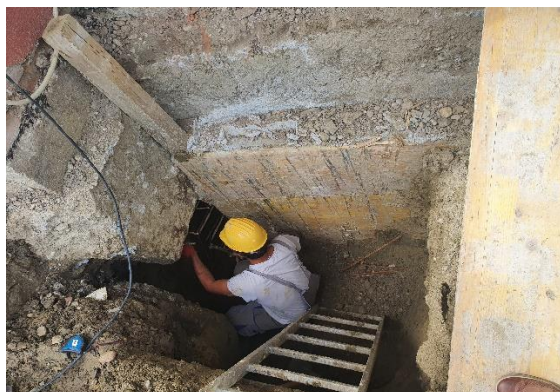
Slika 3 i 4. TS 110/35/10 kV Prelog ojačanje zidova i temelja
