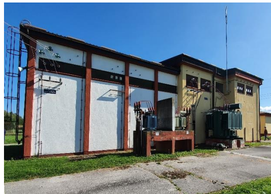
Slika 1 i 2. TS 110/35/10 kV Prelog – stanje prije rekonstrukcije
