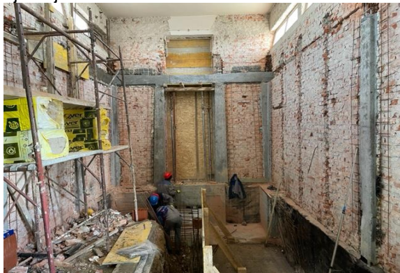
Slika 3 i 4. TS 110/35/10 kV Prelog ojačanje zidova i temelja
