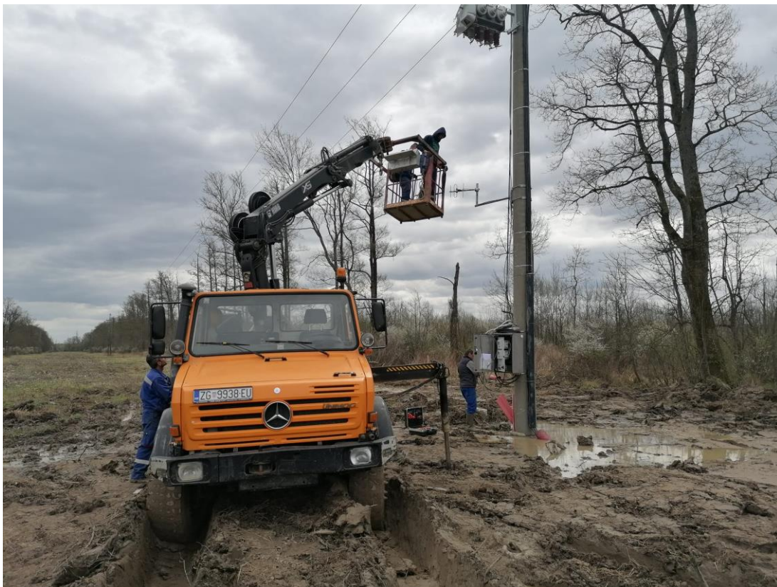
Slika 7. Lokacija ugradnje DURN-a
