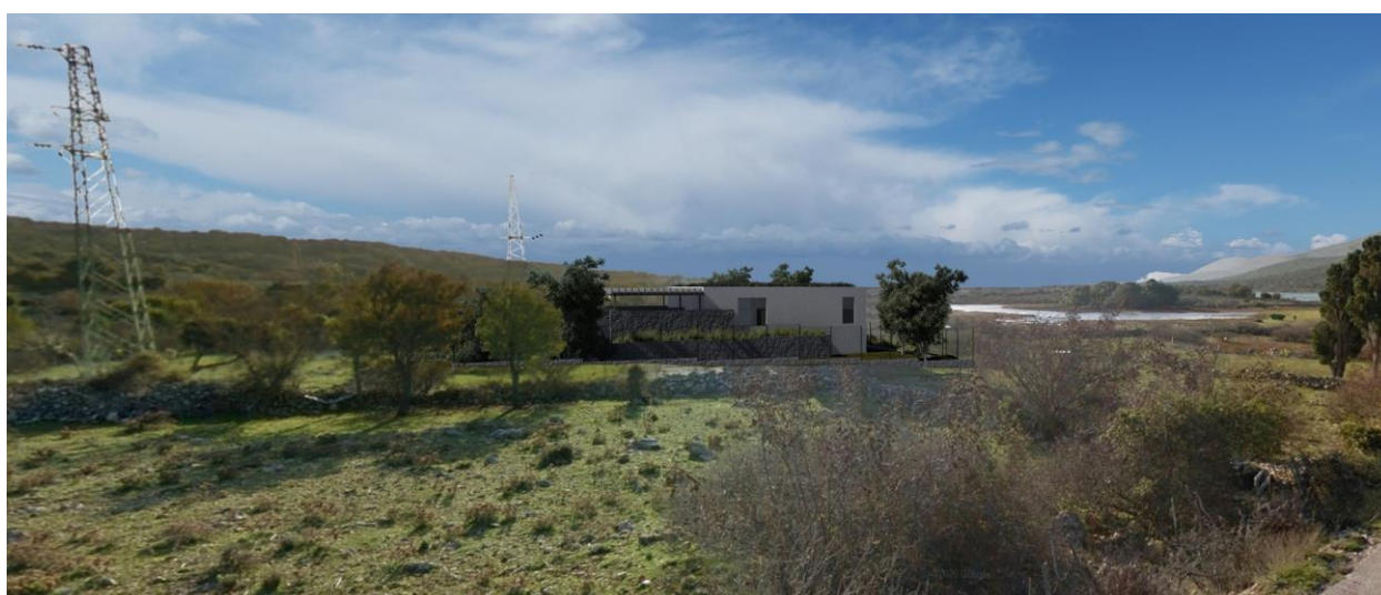
Slika 4. Fotografija postojeće TS i vizualizacija buduće (projektirane) trafostanice
