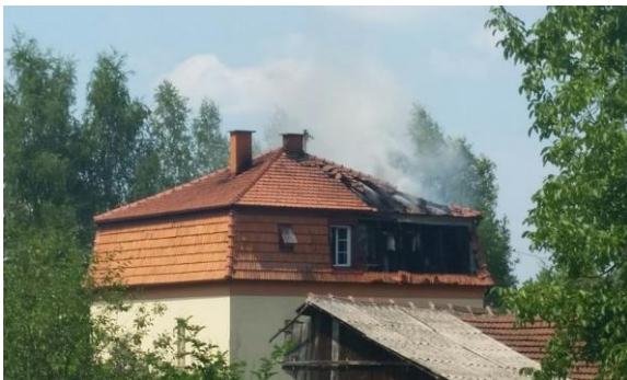
Slika 2. Požar obiteljske kuće
