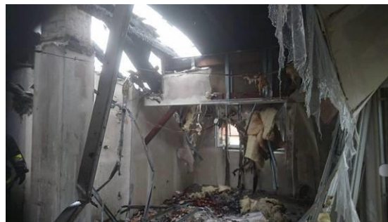
Slika 11. Oštećenja u potkrovlju kuće
