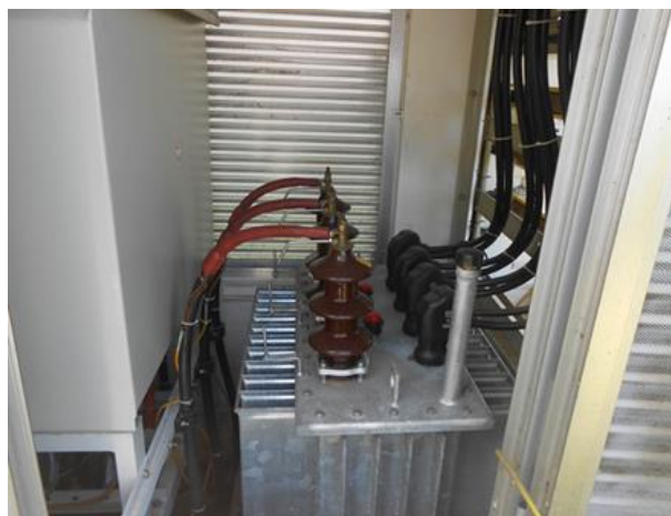
Slika 6. Transformator 10(20)/0,4 kV prije i poslije čišćenja
