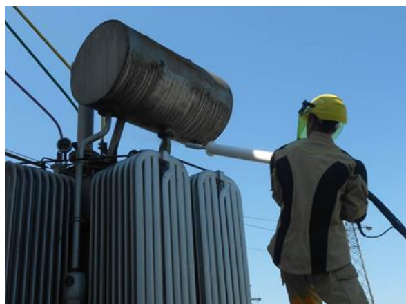
Slika 6. Transformator 10(20)/0,4 kV prije i poslije čišćenja
