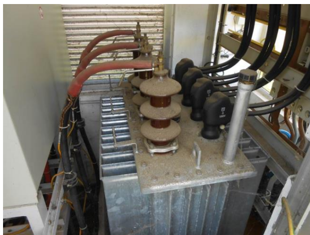
Slika 6. Transformator 10(20)/0,4 kV prije i poslije čišćenja
