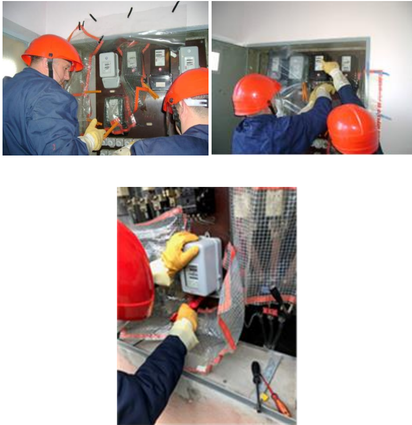
Slika 2. Elektromonter pri radu pod naponom na zamjeni brojila
