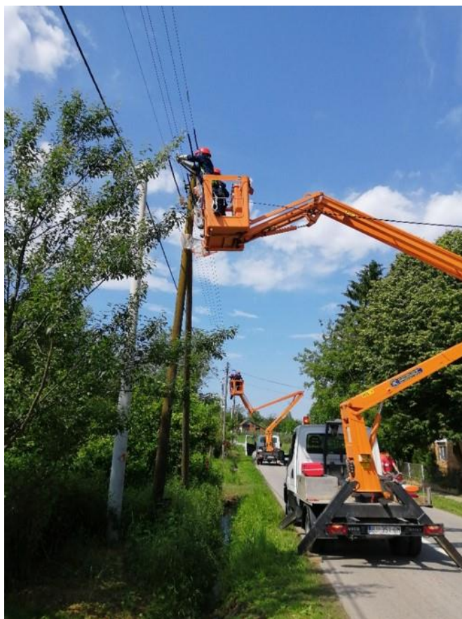
Slika 4. Elektromonter pri radu pod naponom na NN mreži s golim vodičima
