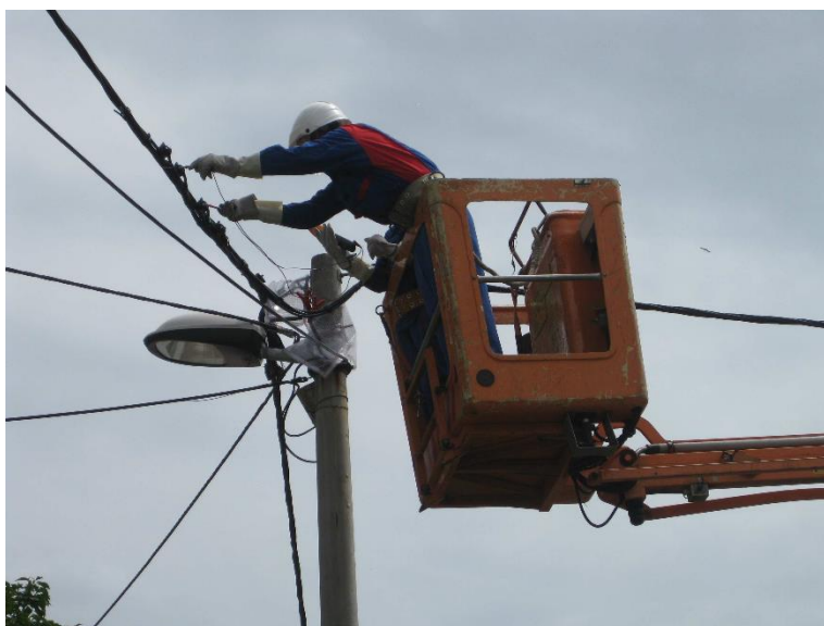
Slika 1. Elektromonter pri radu pod naponom na NN mreži s izoliranim vodičima
