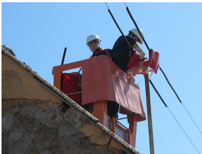
Slika 5. Popravak izolatora pod naponom
