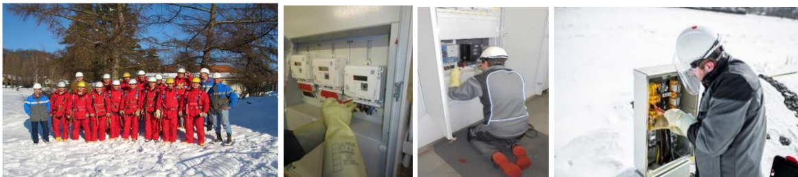
Slika 2. Tim izvođača RPN i prikaz radova na promjeni brojila u KNG [53]
