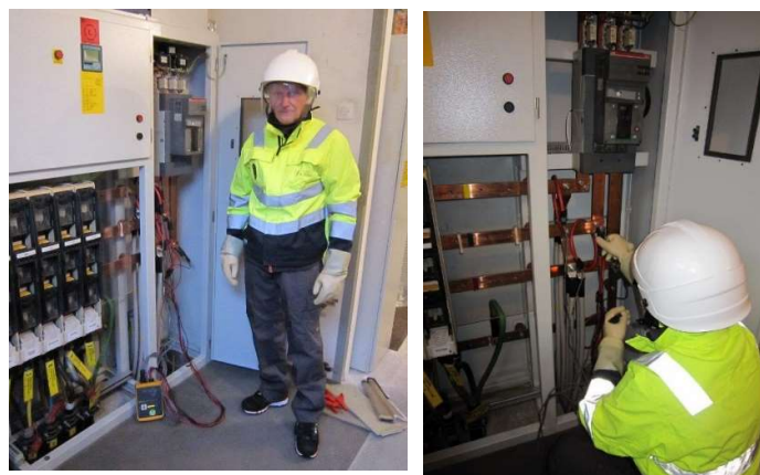
Slika 5. Mjerenje KEE i prikaz OZO kompleta i sigurna ugradnja mjerne garnitura (foto: Štern)
