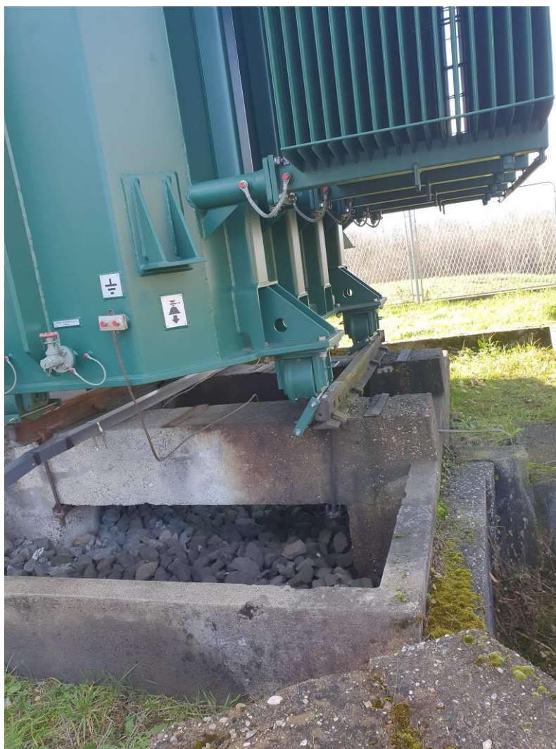
Sl. 2.: Prikaz pomaka Tr 2 35/20 kV, 16 MVA s tračnica u TS 35/20 kV Sisak 2
