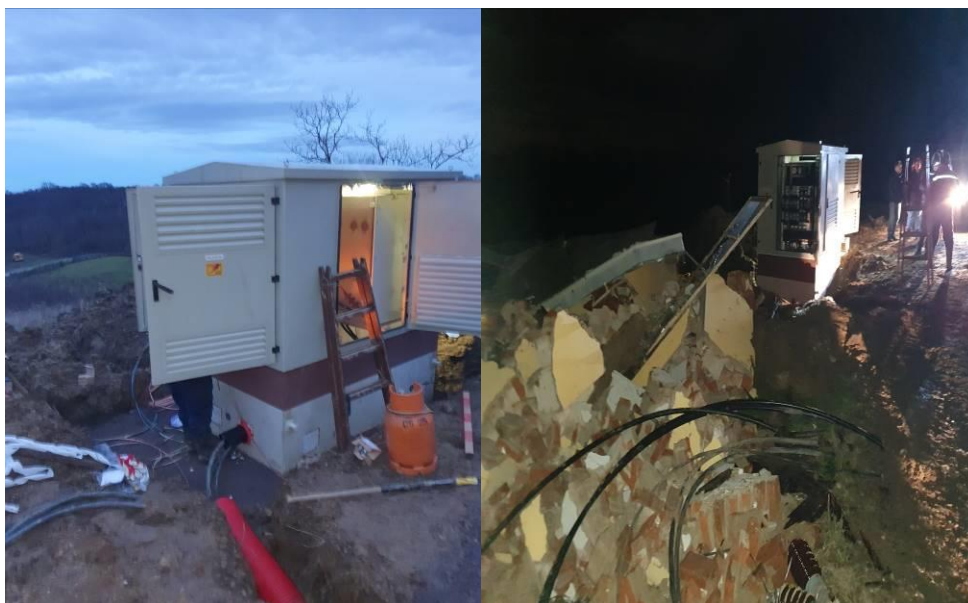
Sl. 3.: Izgradnja JKTS 20/0,4 kV, 160 kVA Cepeliš 01.01.2021.
