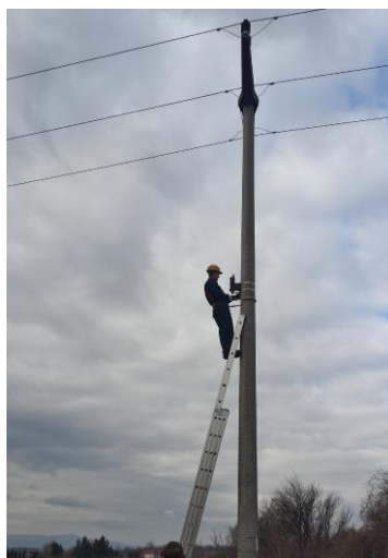
Slika 5 Montaža indikatora kvara na stup 10 kV dalekovoda Tominovac
