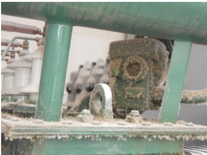
Čišćenje TS 10/0,4 kV Sirač 3-Kumal, Terenska jedinica Daruvar prije i poslije čišćenja
