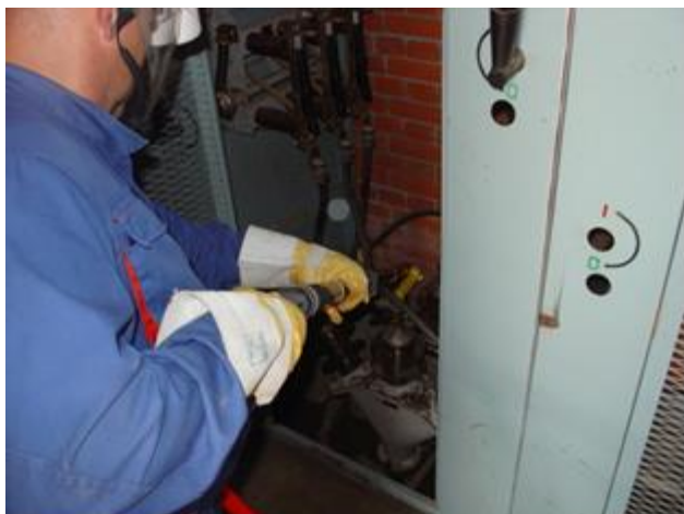
Čišćenje ćelija unutar KTS-a
