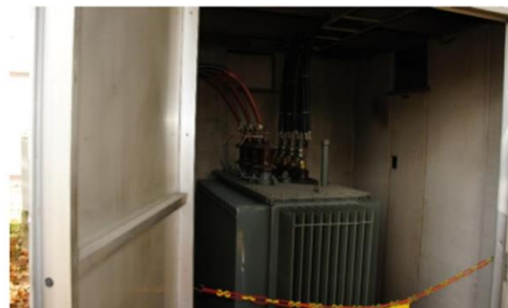
Transformator pred čišćenjem
