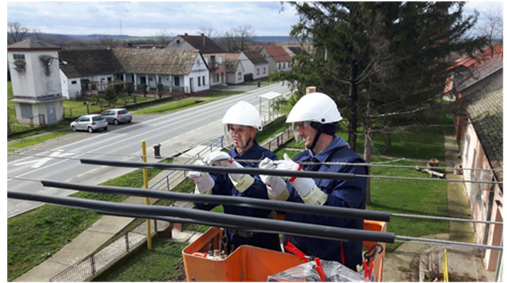
Popravak vodiča MRNN Bračevci, metodom RPN
