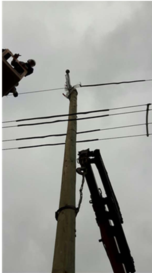
Izmjena drvenog stupa dok je mreža pod naponom
