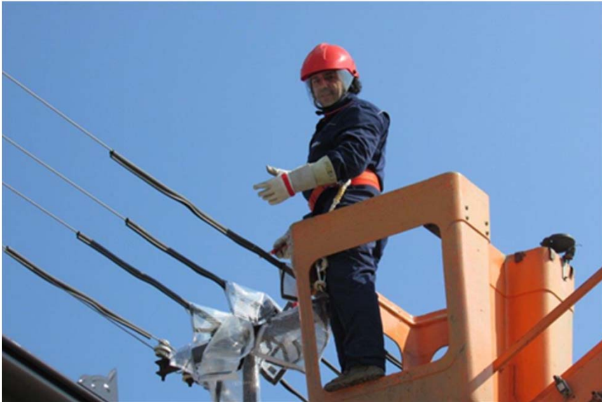
Monter iz Pogona Đakovo u procesu RPN, izmjena izolatora
