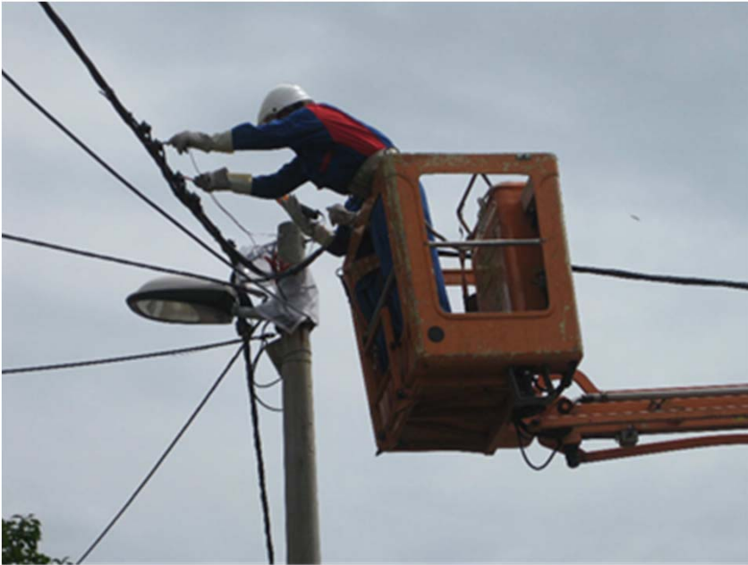
Elektromonter Elektroprimorja pri radu pod naponom
