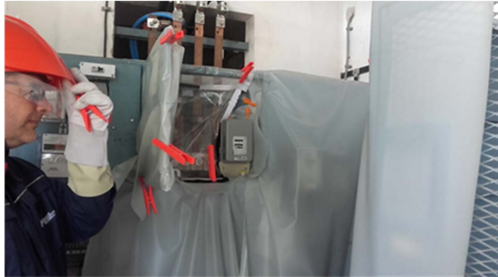
Elektromonter Elektroslavonije Osijek pri radu pod naponom
