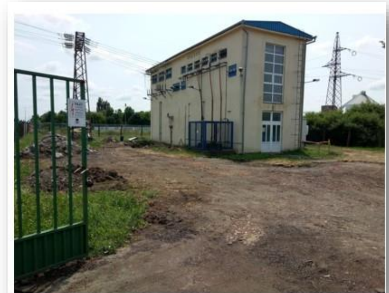
Zgrada postrojenja TS 35/10(20)kV Županja 1
