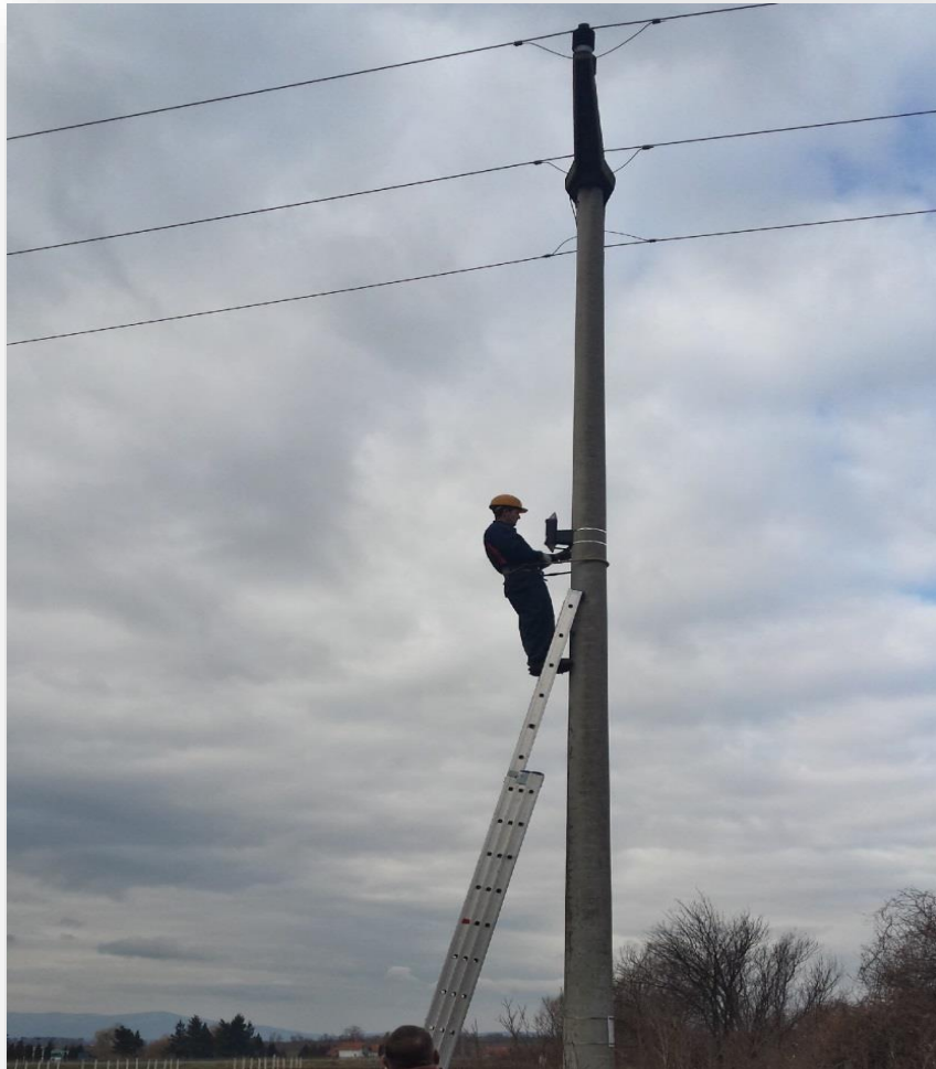
Slika 1. Montaža indikatora kvara na stup
