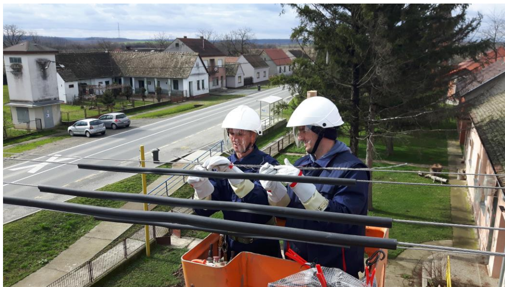
Slika 5. Popravak vodiča MRNN Bračevci, metodom RPN
