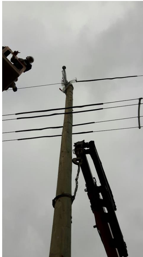
Slika 6. Izmjena drvenog stupa dok je mreža pod naponom
