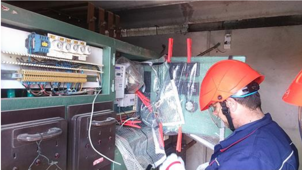
Slika 1.RPN, travanj 2016. – odjel mjerenja, izmjena brojila
