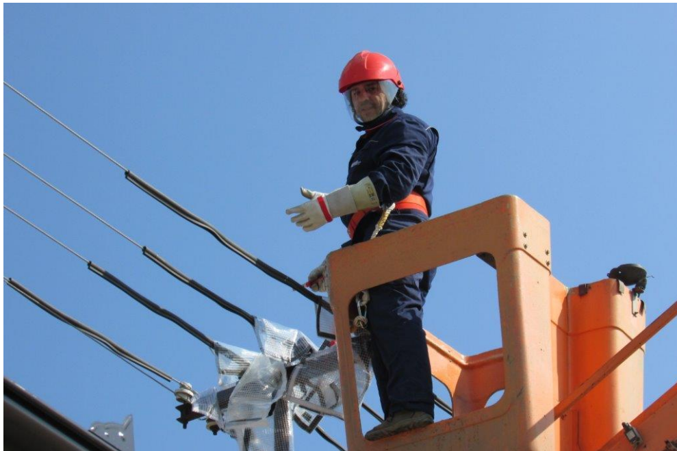
Slika 4. Monter iz Pogona Đakovo u procesu RPN, izmjena izolatora
