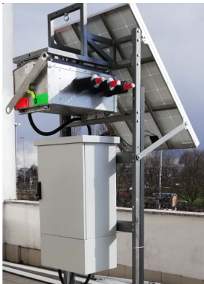
Slika 1 – Vakuumska rastavna sklopka i ormar s upravljačkom jedinicom i solarnim napajanjem
